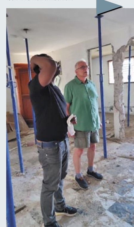
Karlheinz und Dieufort Wittmer beim Prüfen der Bausubstanz im alten Mitarbeiterhaus
