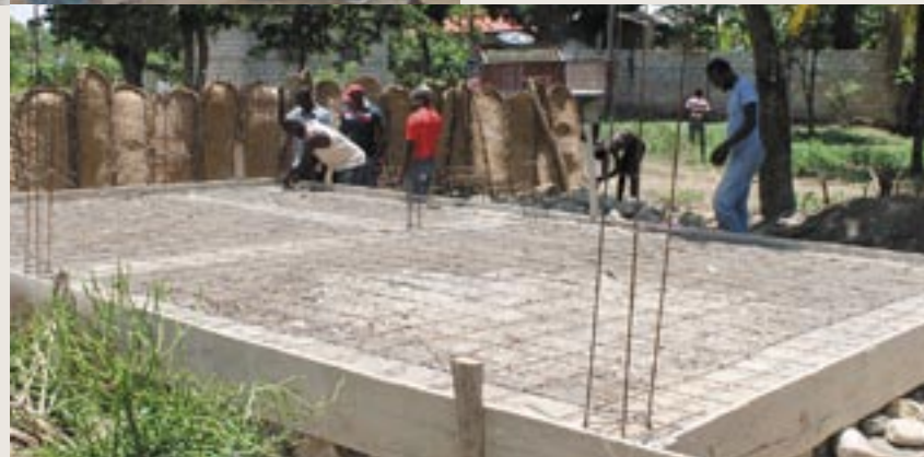
Unten: Herstellung der Bodenplatte
